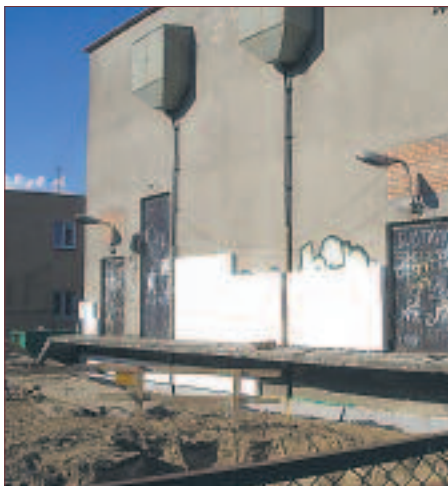
▲ Trwa przebudowa systemu odprowadzania wód deszczowych
