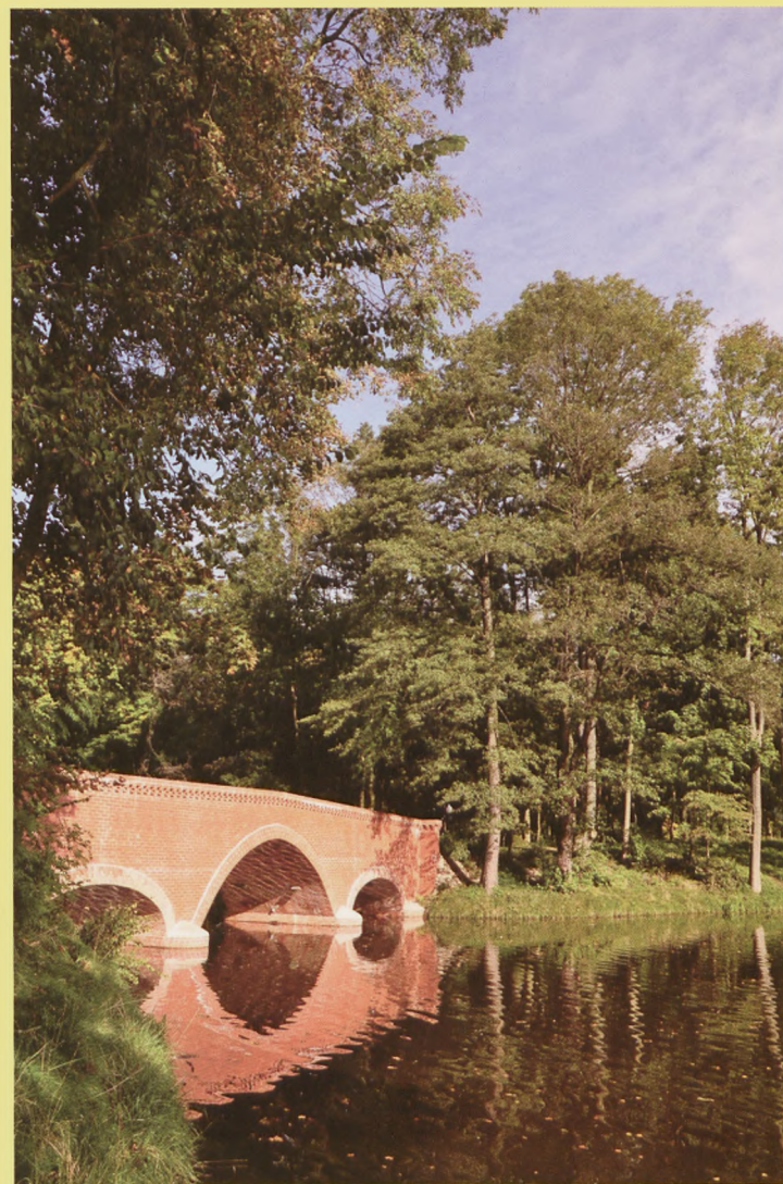
Odbudowany trójprzęsłowy ceglany most.
