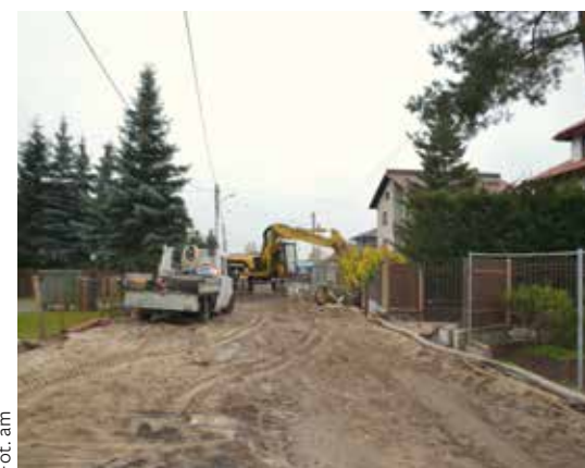
Kontynuacja budowy ul. Kwiatów Polskich w Międzyzlesiu. Pierwszy etap to układanie sieci wodociągowej i kanalizacyjnej
