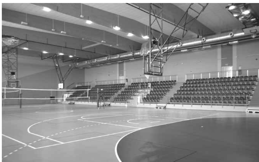
Hala widowiskowo - sportowa.
