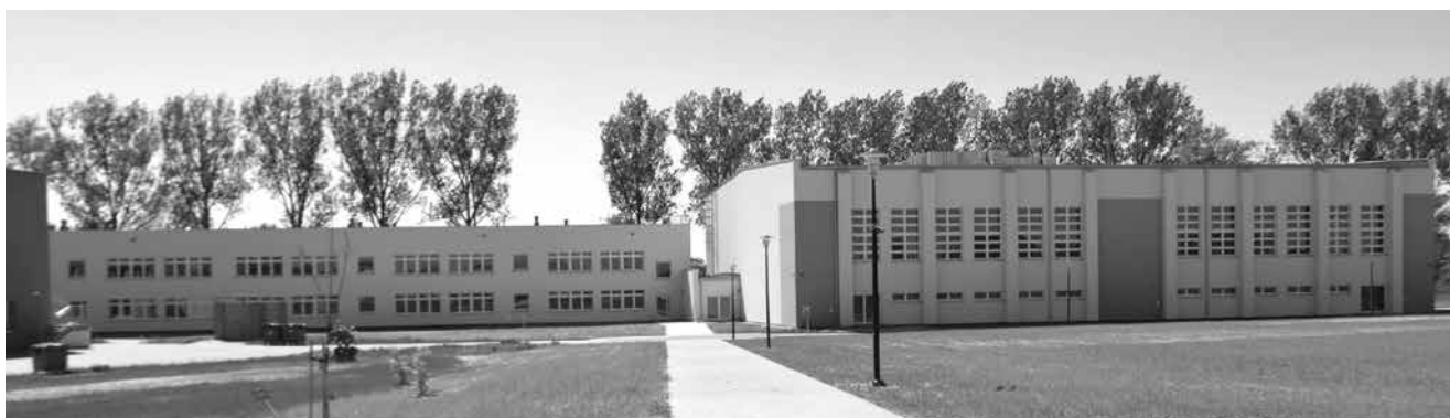
Nowe skrzydło kompleksu oświatowego od strony „Orlika”.
