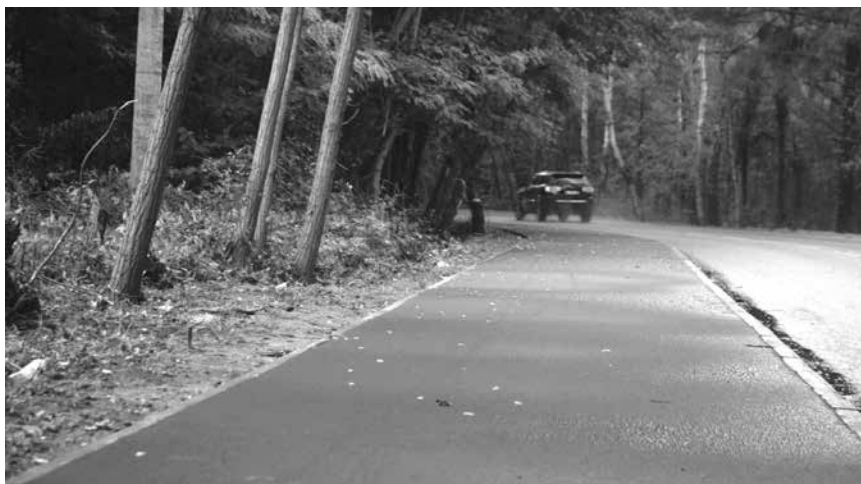
Fragment powstającej ścieżki rowerowej w Strzeniówce.
