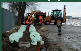
Budowa ścieżek rowerowych s. 12
