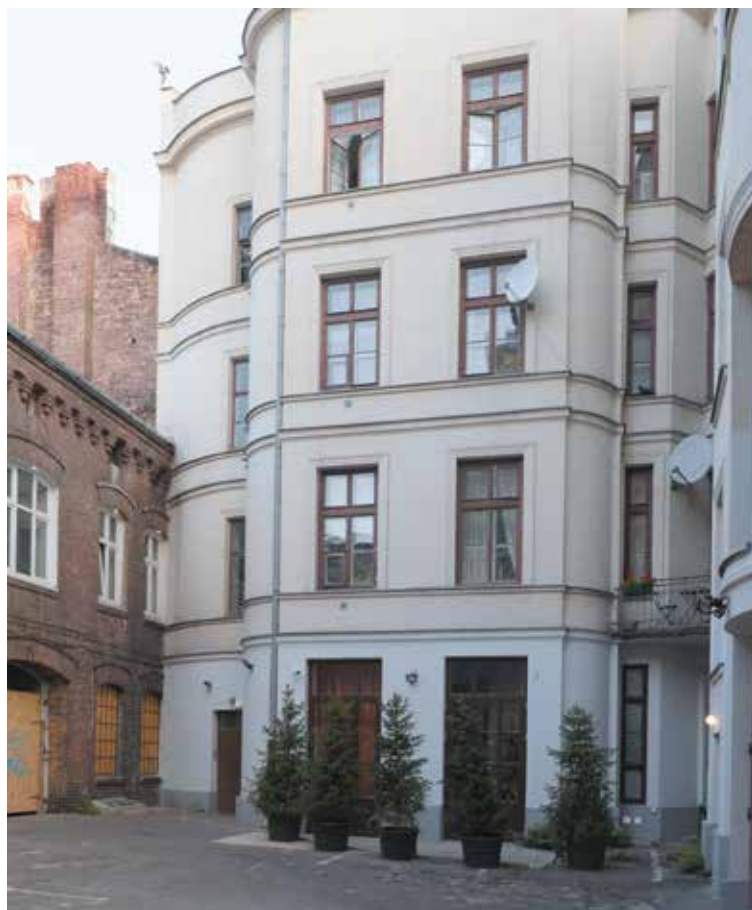
Oficyna zachodnia łącząca kamienicę z zabudowaniami fabrycznymi
