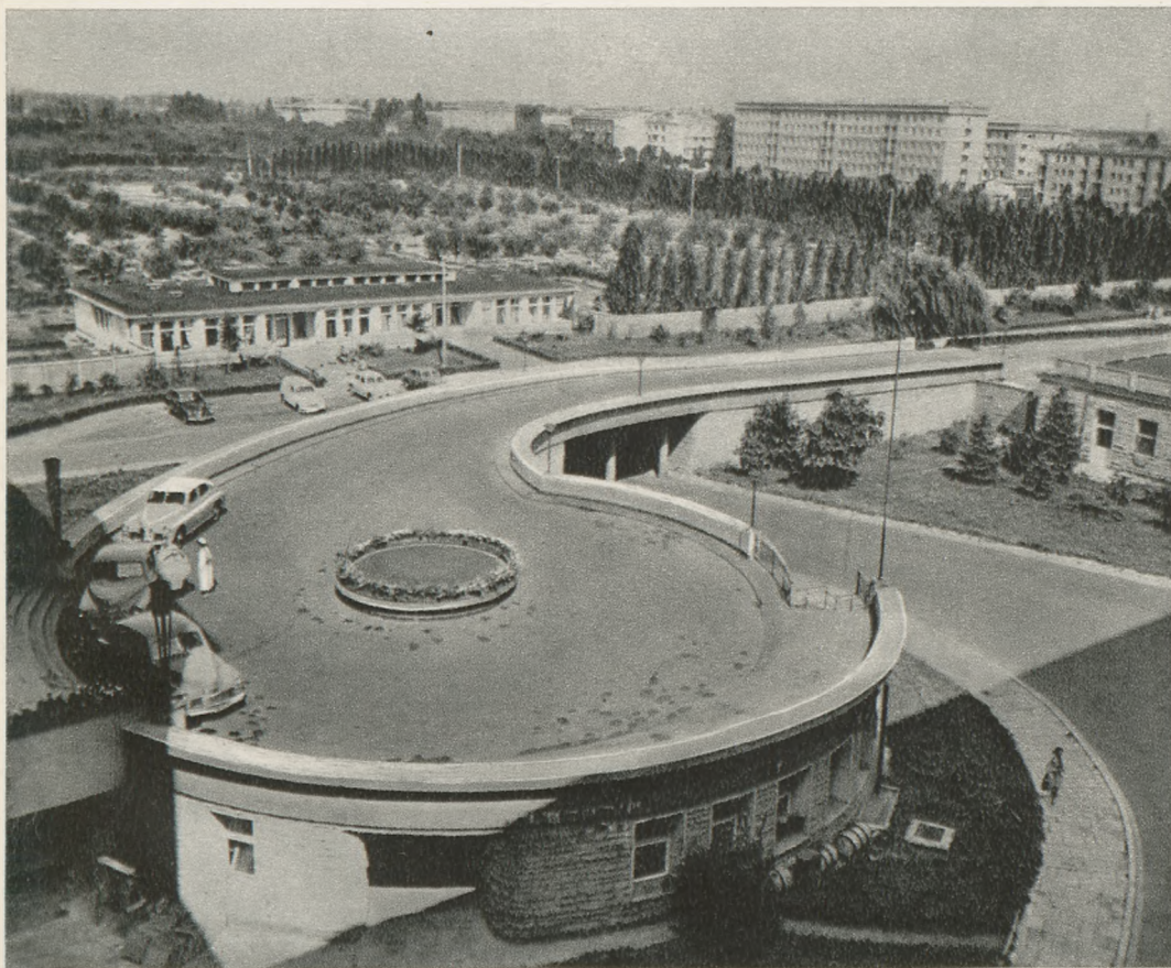
Podjazd do wejścia głównego. Na drugim planie żłobek dla dzieci pracowników. Proj. arch. Alicja Lachowicz
