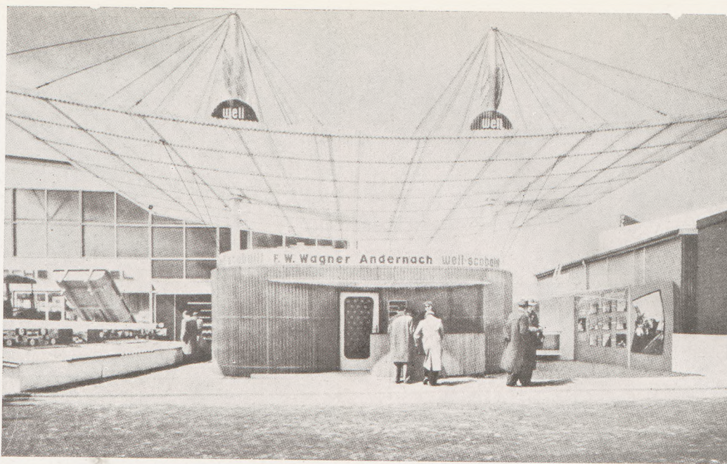
Jedno ze stoisk wystawowych na wystawie materiałów budowlanych w Berlinie. Lekki wiszący dach z przezroczystego tworzywa falistego „scobalit”
