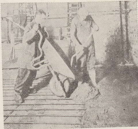
Wykonanie izolacji stropu grzejnego z betonu „Vermiculite”
