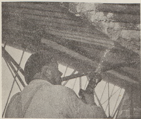
Natrysk warstwy izolacyjnej z wełny mineralnej „Pyrolaine”
