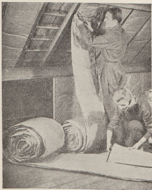
Zakładanie mat z wełny mineralnej „Rollisol”
