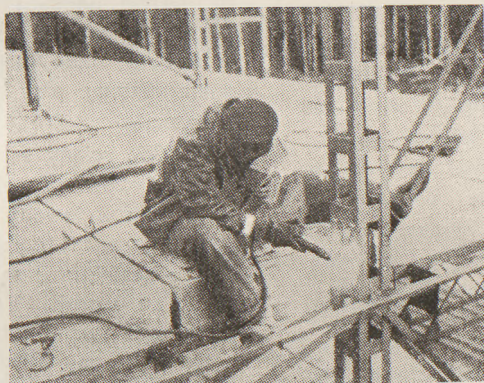
36. Słupy składające się z kształtowników Wznosi się je piętrowymi odcinkami, które są spawane
