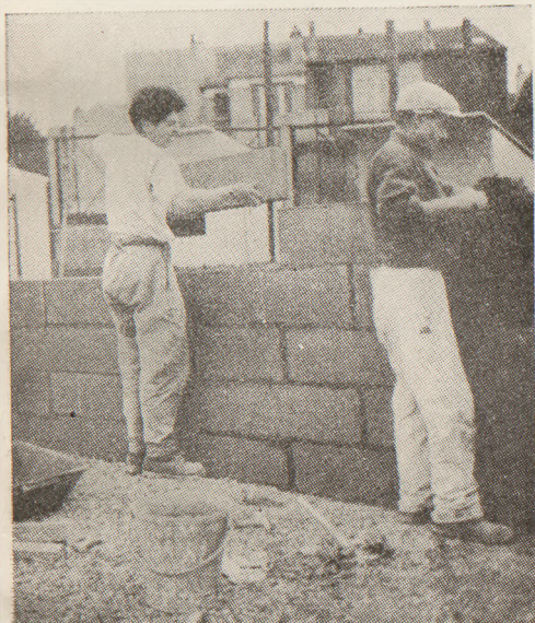
Beton korkowy: wykonywanie ścian z bloków „Bétoliège”
