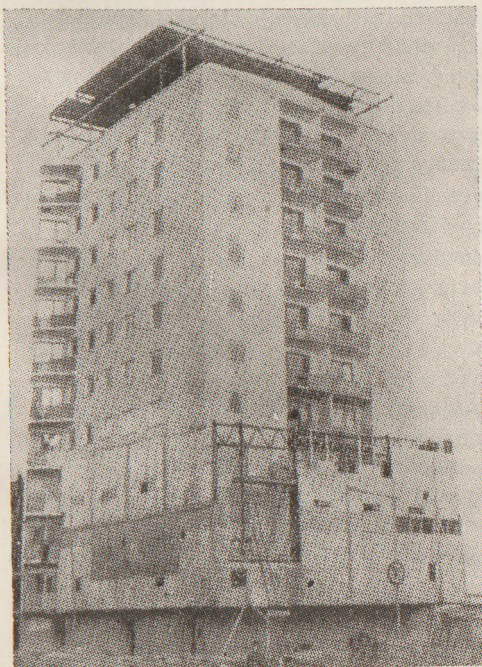
33. Po zakończeniu montażu ściany hali opuszczane są na prowadnicach. Jednocześnie ściany zewnętrzne budynku są pokrywane tynkiem elewacyjnym. Wokół zewnętrznego obwodu budynku przymocowane są do konstrukcji hali rusztowania dla tynkarzy, które służą
