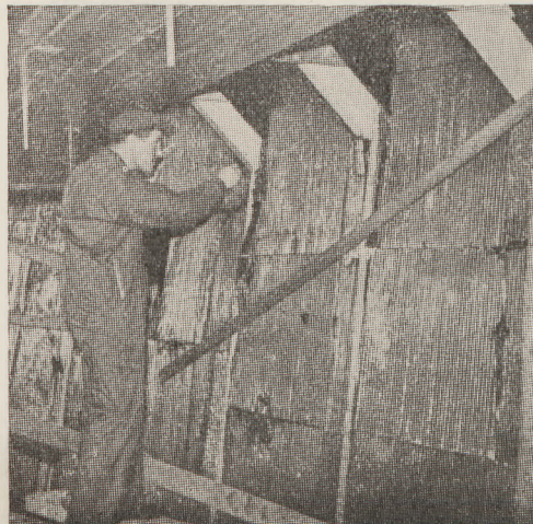
Układanie folii aluminiowej
