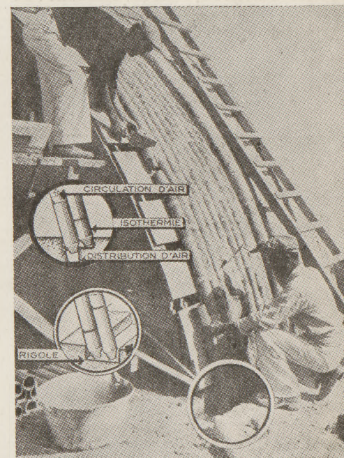
Wykonanie izolacji termicznej sklepienia przy pomocy rur ceramicznych
