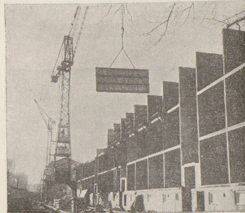
14. Deskowanie ściany nośnej transportowane za pomocą dźwigu. Boczne elementy deskowania — belki dwuteowe — są usunięte
