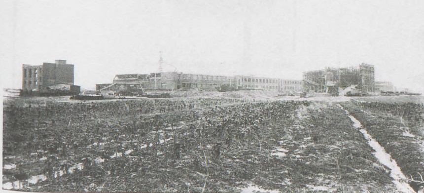
Budowa Fabryki Jedwabiu w Chodakowie, 1927 r.
