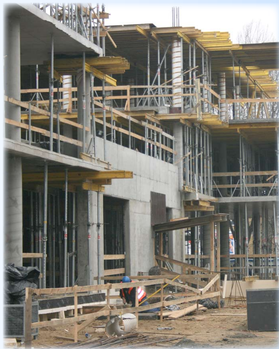
Na budowie, 2008 r.
