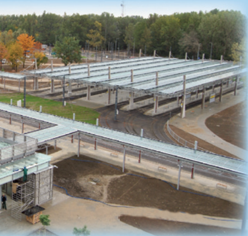
Panorama Węzła Komunikacyjnego Młociny – październik 2008 r.
