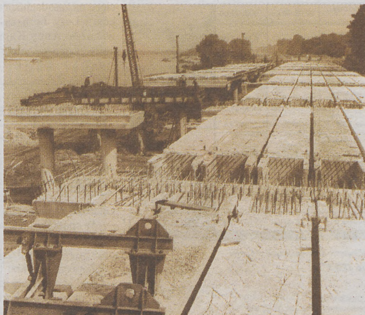
Budowa Wisłostrady, 1973 r.
