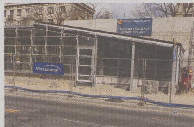
Stacja Stare Bielany w budowie
