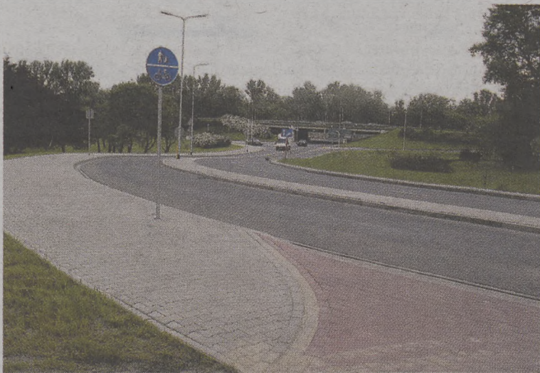
Nowa nawierzchnia na jezdni i chodniku
