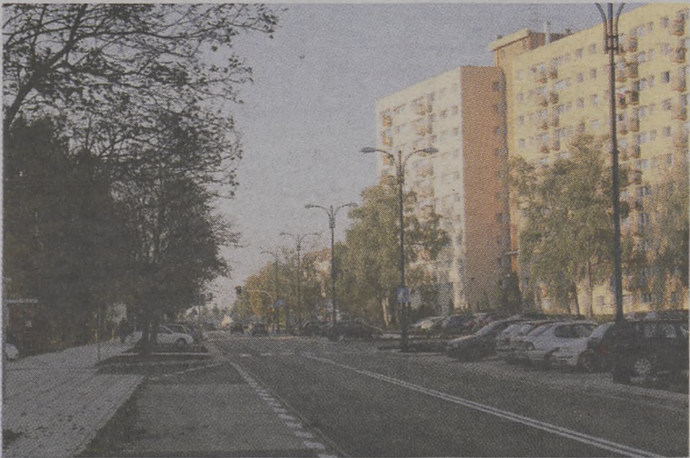
... i po remoncie
