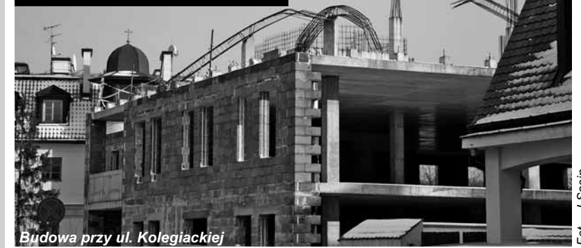
Budowa przy ul. Kolegiackiej
