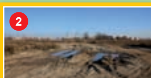
Budowa ul. A. Branickiego (dawniej Plaskowickiej bis), Wilanów Zachodni
