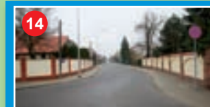
Przebudowa ulicy Obornickiej Wilanów Niski
