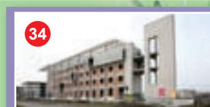
Ratusz; prowadzone są procedury zmierzające do wznowienia budowy
