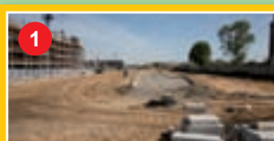
Budowa al. Rzeczypospolitej, Wilanów Zachodni
