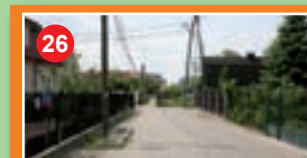
Budowa odcinka ul. Uprawnej przy szkole w Powsinku
