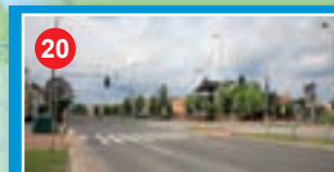
Przebudowa skrzyżowania ulic: Wiertniczej i Lentza z sygn. świetlną
