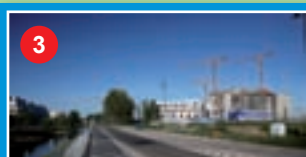
Budowa ul. ks. prymasa Hłonda; Wilanów Zachodni
