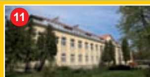
Remont i nadbudowa piętra w Zespole Szkół nr 79
