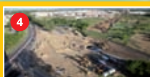
Budowa al. Wilanowskiej i skrzyżowania z al. Rzeczypospolitej i ul. Sobieskiego
