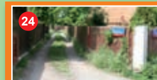
Budowa ul. Biwakowej w Powsinku
