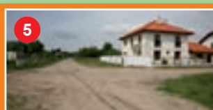
Budowa ulicy oznaczonej symbo- lem L3 w rejonie os. Arbuzowa
