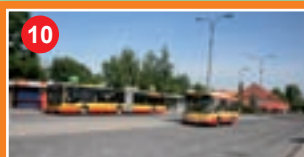
Przebudowa pętli autobusowej przy ul. Wiertniczej
