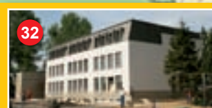
Przebudowa budynku dla: biblioteki, centrum kultury i ośrodka pomocy społecznej.
