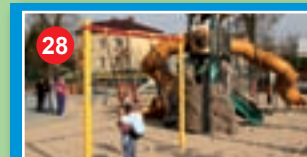
Budowa placu zabaw przy ul. Gronowej w Powsinie
