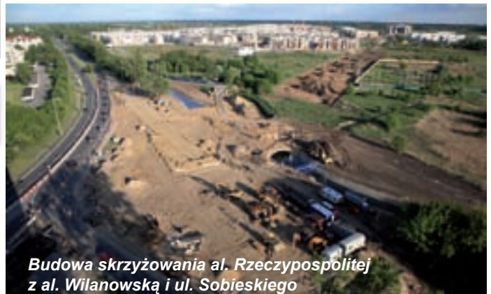
Budowa al. Rzeczypospolitej
