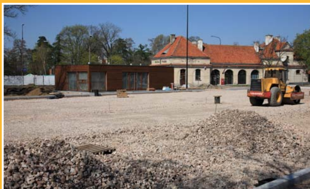
Budowa parkingu przy ul. St.K. Potockiego i toalety publicznej
