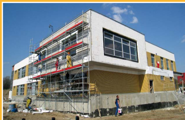
Budowa przedszkola publicznego przy ul. Sytej 123
