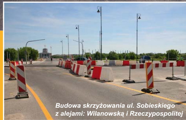
Al. Rzeczypospolitej w budowie (widok od ul. Klimczaka)
