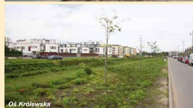
Przebudowa ul. Przyczółkowej
