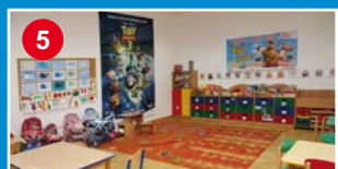
Przebudowa pomieszczeń na oddział dla sześciolatków w Zesp. Szkół nr 79
