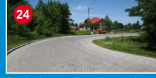
Przebudowa pętli autobusowej na Kępie Zawadowskiej
