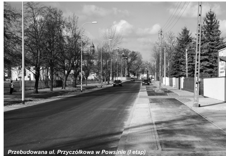
Przebudowana ul. Przyczółkowa w Powsinie (I etap)
