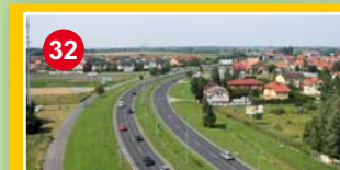
I etap budowy ul. Nowokabackiej (skrzyżowanie z ul. Ł. Drewny)
