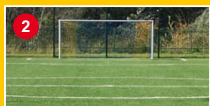
Budowa boiska ORLIK 2012, Wilanów Zachodni
