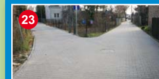
Remont ulic w Powsinku
