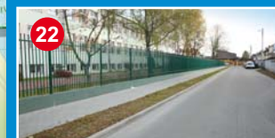
Budowa odcinka ul. Uprawnej przy szkole w Powsinku
