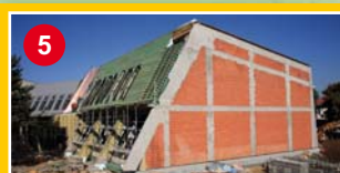
Budowa hali sportowej wraz z pływalnią w Zespole Szkół nr 79
