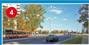
Budowa al. Wilanowskiej oraz skrzyżowania z al. Rzeczypospolitej i ul. Sobieskiego
