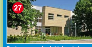
Budowa przychodni lekarskiej przy ul. Przyczółkowej w Powsinie
