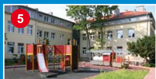
Budowa placu zabaw w Zespole Szkół nr 79
