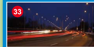
Budowa oświetlenia ul. Przyczółkowej i ul. Łukasza Drewny
