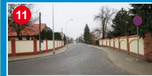
Przebudowa ulicy Obornickiej; Wilanów Niski
