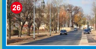
I etap przebudowy ul. Przyczółkowej przebiegającej przez Powsin
