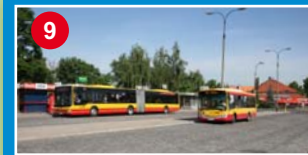
Przebudowa pętli autobusowej przy ul. Wiertniczej
