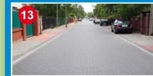
Przebudowa ul. Piechoty Łanowej w Wilanowie Niskim
