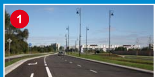
Budowa pierwszego odcinka alei Rzeczypospolitej; Wilanów Zachodni
