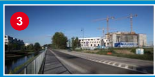
Budowa ul. Ks. Prymasa Hłonda; Wilanów Zachodni
