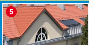
Remont gmachu i nadbudowa piętra w Zespole Szkół nr 79
