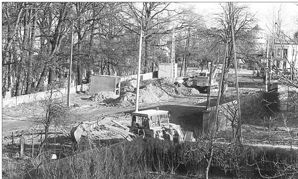
Piaseczno, lata osiemdziesiąte XX w. przebudowa obecnej ulicy T. Gerbera w związku z budową kanalizacji sanitarnej.
