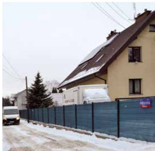
Na liście tegorocznych inwestycji wodno-kanalizacyjnych znalazła się m.in. ul. Arktyczna
