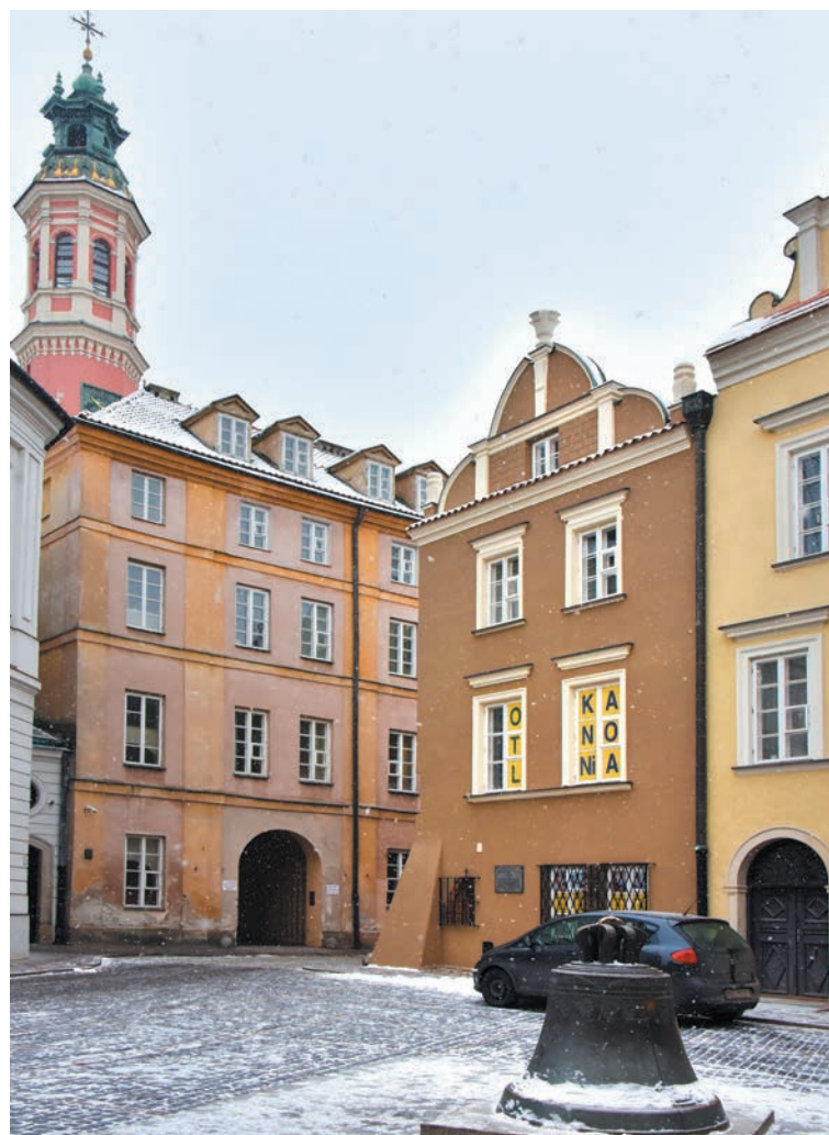
Podczas remontu m.in.: naprawiono tynki i elementy architektoniczne, wymieniono okna i dach, przywrócono oryginalny kolor elewacji
