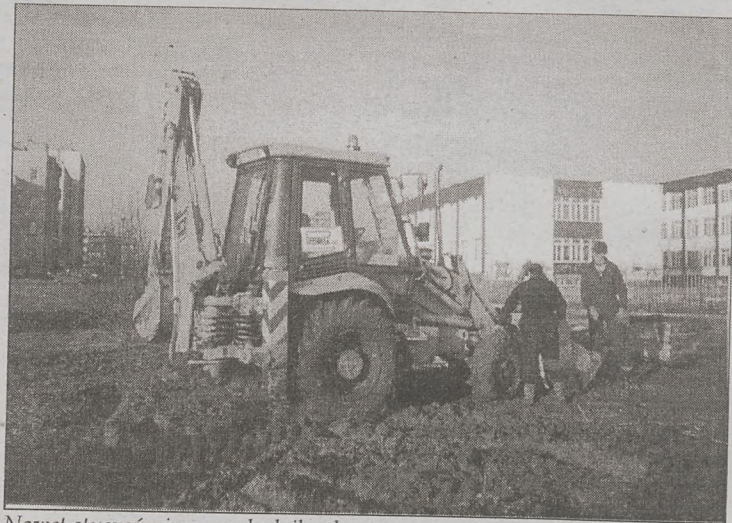
Nawet styczeń nie przeszkodził w kontynuowaniu prac.
