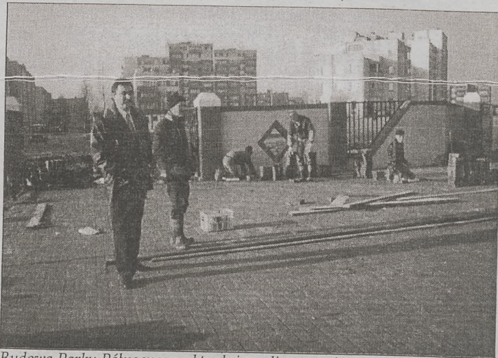
Budowa Parku Północnego, aktualnie realizowana inwestycja przebiega pod czujnym okiem Zbigniewa Strzałkowskiego (pierwszy z lewej).
