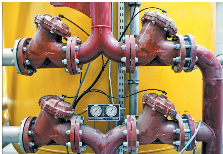
Po rozbudowie stacji uzdatniania wody przy ul. Żeromskiego w Piasecznie przyszedł czas na rozbudowę SUW w Złotokłosie Foto Marcin Borkowski/URZĄD MIASTA
