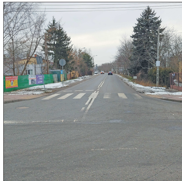
W II etapie przebudowy ul. Geodetów powstanie m.in. rondo u zbiegu z ul. Julianowską
