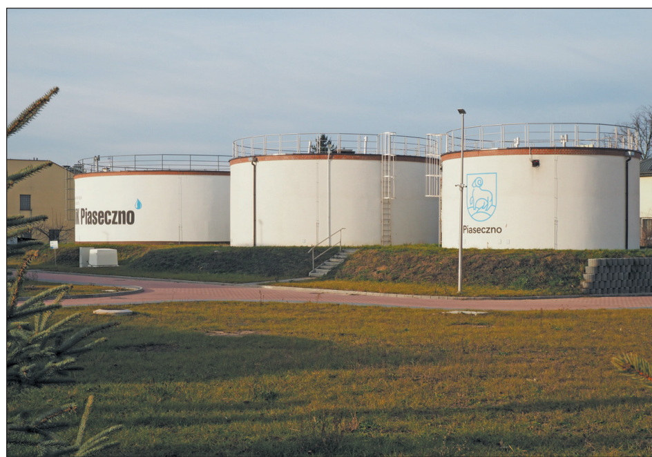
Zmodernizowana Stacja Uzdatniania Wody przy ul. Żeromskiego
