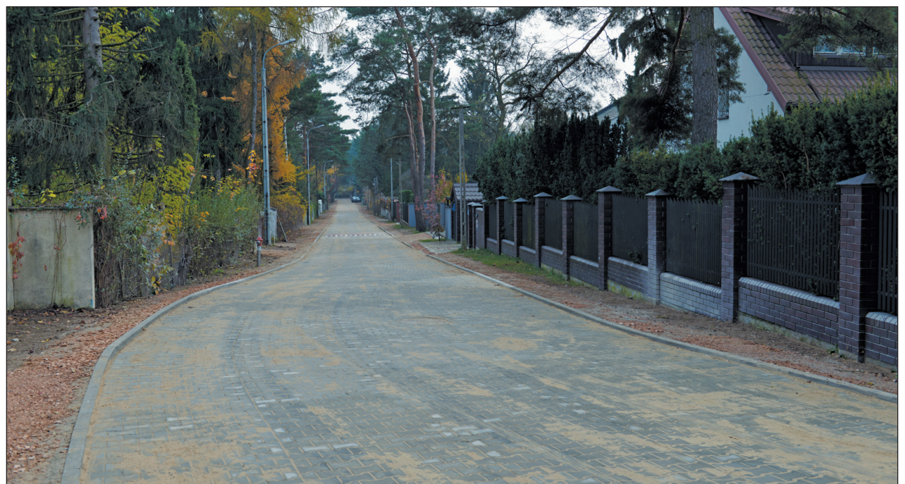
Wyremontowana ulica Kwiatowa w Zalesiu Dolnym
