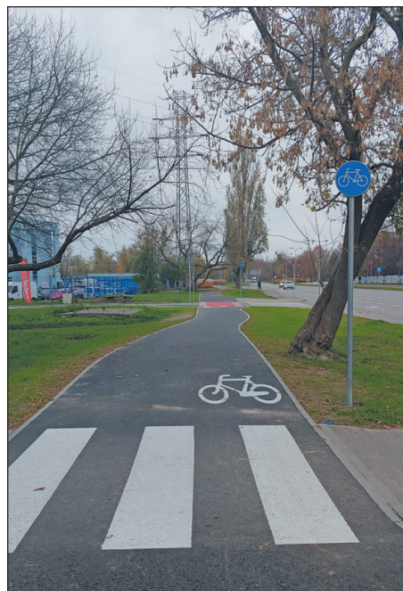
Ścieżka rowerowa przy ul. Energetycznej
