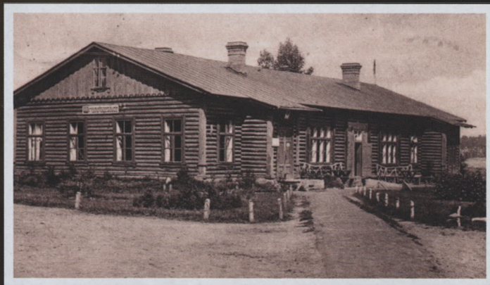
drewniany budynek koszarowy, 1917 r.
