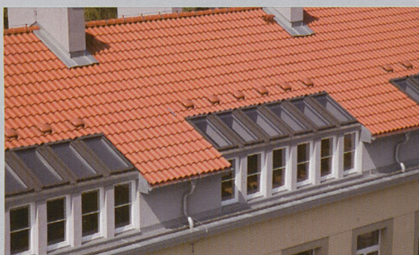
Nadbudowane piętro z nowym dachem
