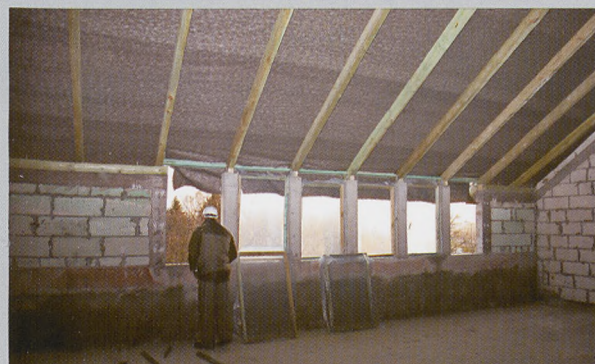
Sala lekcyjna w budowie
