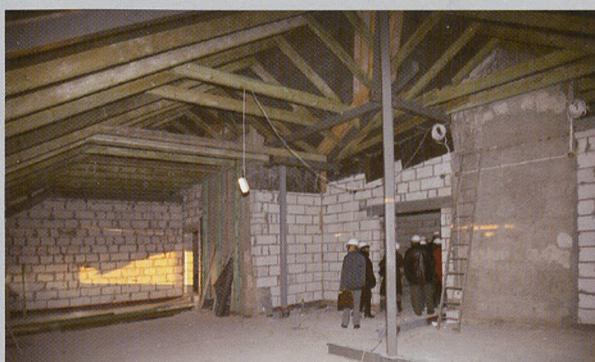
Sala multimedialna w trakcie budowy
