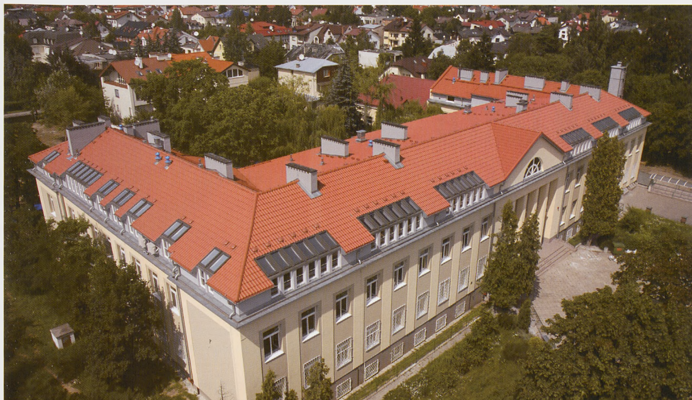
Budynek Zespołu Szkół nr 79 przy ul. Wiertniczej 26 z nadbudowanym piętrem, nowym dachem i nową elewacją prezentuje się okazale.
