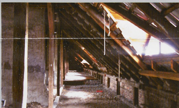
Poddasze przed remontem
