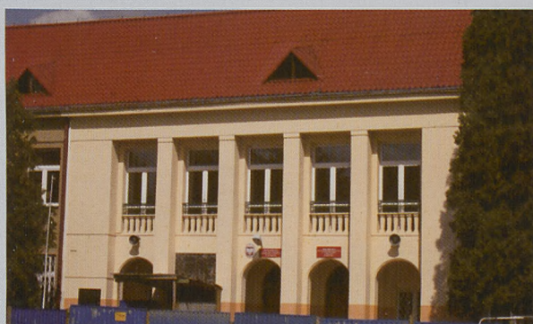
Front budynku przed remontem
