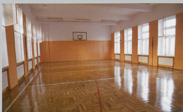
Odnowiona sala gimnastyczna
