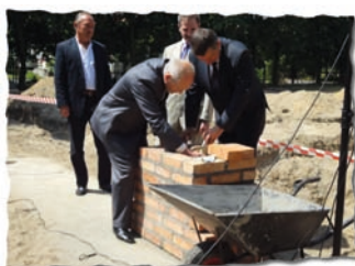
tubę umieszczono w fundamencie
