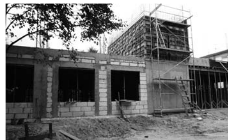
Ośrodek Zdrowia – już budowane jest piętro
