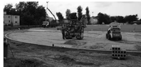
Budowa boiska przy SP Raszyn
