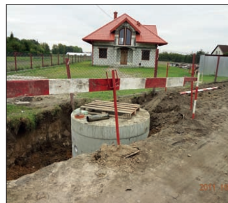
Przepompownia do kanalizacji na Żytniej
