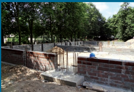
2011.07.13 Już widać zarysy budynku
