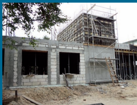
2011.09.19 Już budowane jest pierwsze piętro
