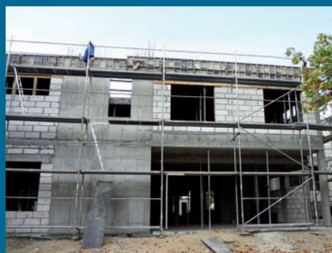
2011.10.06 Pierwsze piętro wybudowane
