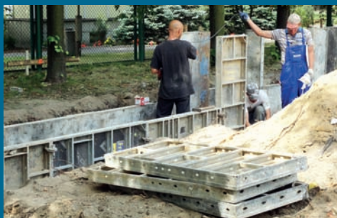
2011.06.22 Rozpoczęto szalowanie fundamentów
