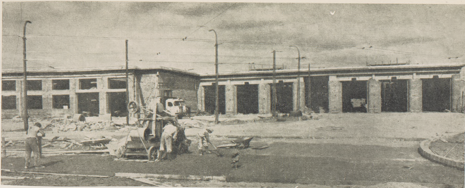
Zajezdnia trolejbusów miejskich przy ul. Czerniakowskiej. Widok hal przeglądów i napraw od południa. Stan robót we wrześniu 1958 r. Fot. A. Funkiewicz
