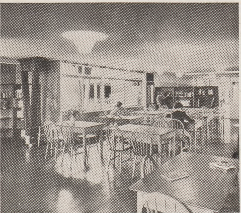
Wnętrze biblioteki. Z lewej strony widoczny jest prefabrykowany słup drewniany w kształcie litery V, zastosowany w całym budynku
