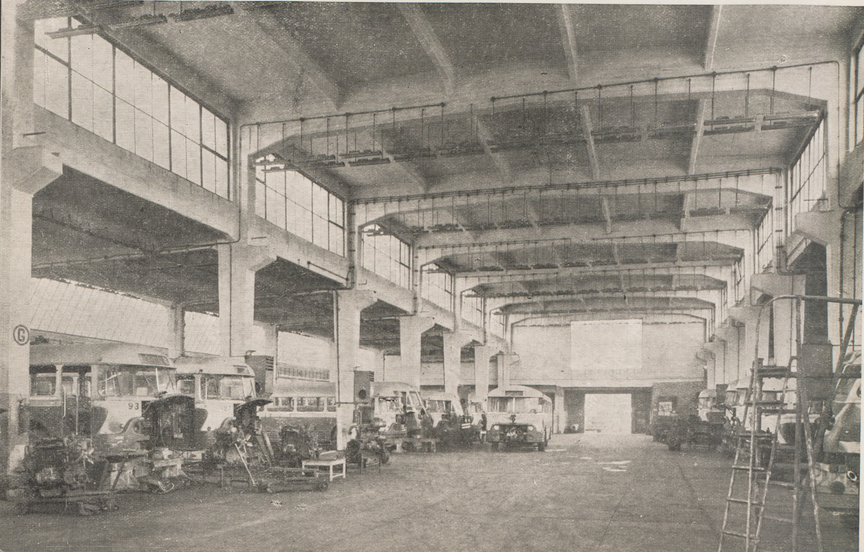
Wnętrze hali napraw Centralnych Warsztatów Samochodowych przy ul. Włociańskiej. Fot. A. Funkiewicz
