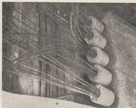
10. Bloki kotwiące na czołach pilastrów
