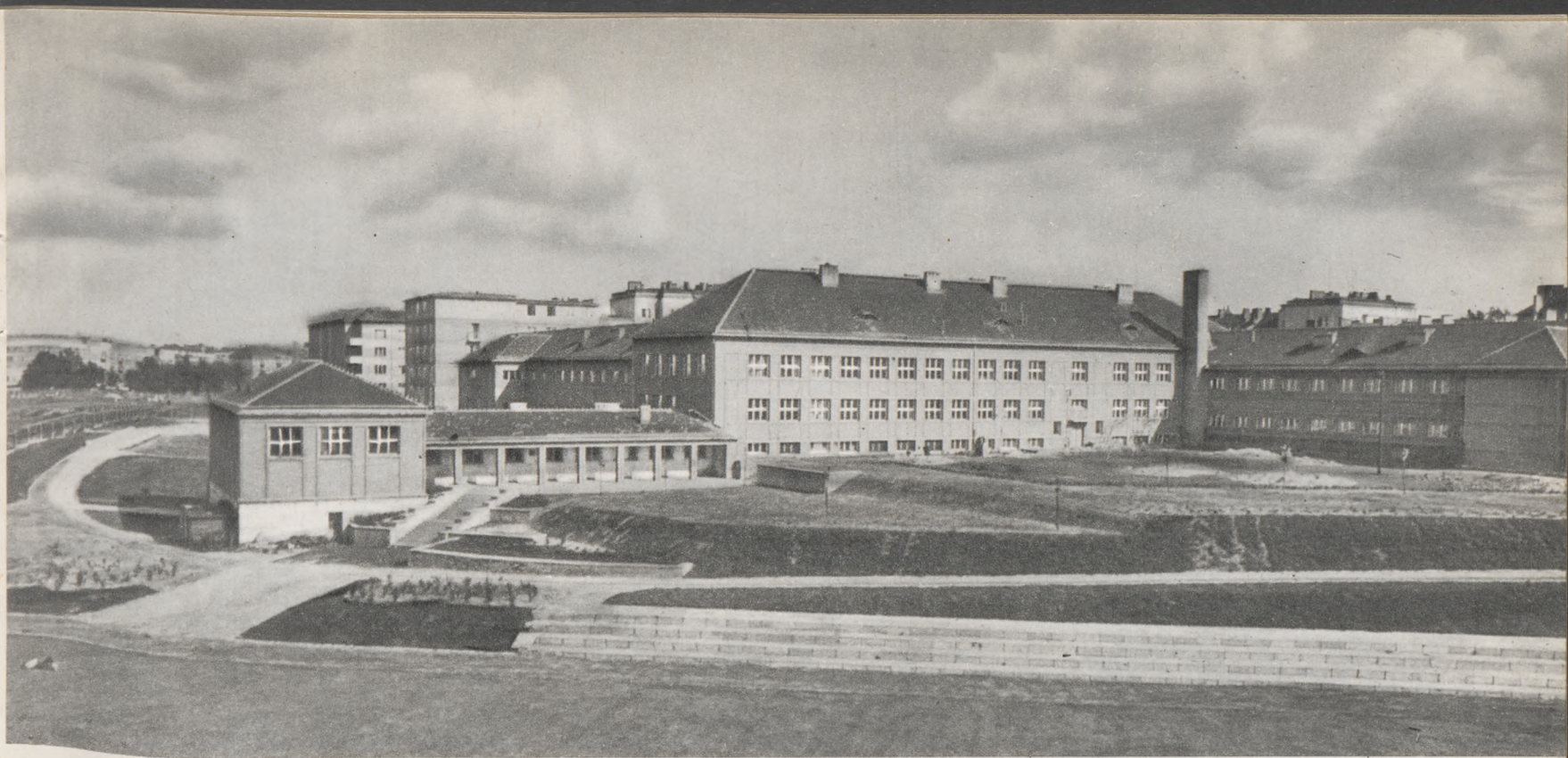
Widok szkoły od strony stadionu
