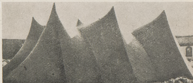
41. Typ ulepszony namiotu misyjnego z dokładnym przycięciem powłoki. Przez zastosowanie silnych krzywizn przestrzennych uzyskano znaczną sztywność, a więc i wytrzymałość na wiatr i deszcz
