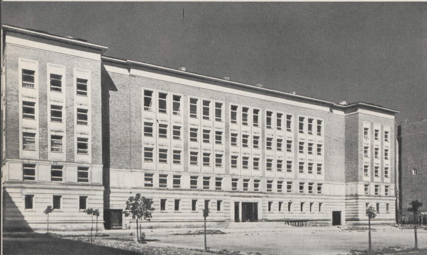
Elewacja od strony dziedzińca szkolnego
