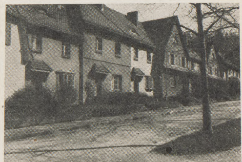
16. Jelenia Góra. Bardzo dobre powiązanie rozmaitych w bryle budynków usytuowanych przy pochylej jezdni. Ładnie rozwiązane przedogródki
