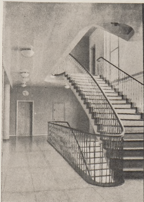
Przykład klatki schodowej biurowca w Kolonii, wykończonych z użyciem tworzyw sztucznych: podłoga, krawężniki stopni, poręcz, powłoki malowane na ścianach i spodach biegów i spoczników
