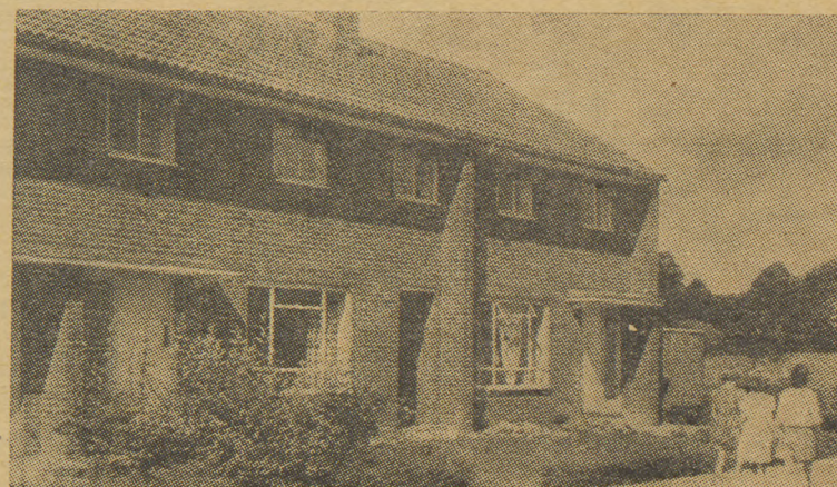
18. Budynki typu „hause” — to typ występujący najczęściej. Są one dwukondygnacyjne, mieszkanie zajmuje segment budynku szeregowego. Na kondygnacji parterowej są pokoje dzieciinne. Na pierwszym piętrze pokoje sypialne i łazienka
