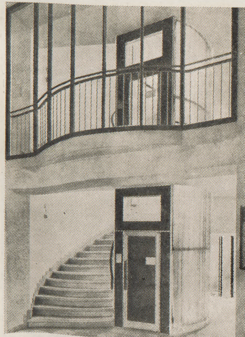
Oszklenie szyby windy tworzywem „Astralon” w Bibliotece w Essen (Niemcy). Drzwi do windy są obłożone płytą melaminową „Ultrapas”
