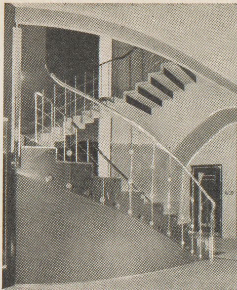
Balustrada schodów wykonana całkowicie z tworzywa przezroczystego „Plexiglas”. Poprzecz z okrągłego pręta o przekroju 50 mm, szczyty wypełniające grub. 8 mm, miejsca styków wzmocnione rozetami. Widoczny w głębi słup świetlny również z „Plexiglas”
