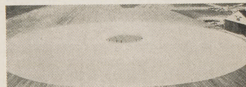
Montaż próbny dachu pawilonu USA z płyt „Kal-Wall”, wykonany na polu startowym lotniska przed wysłaniem ich samolotem do Brukseli
