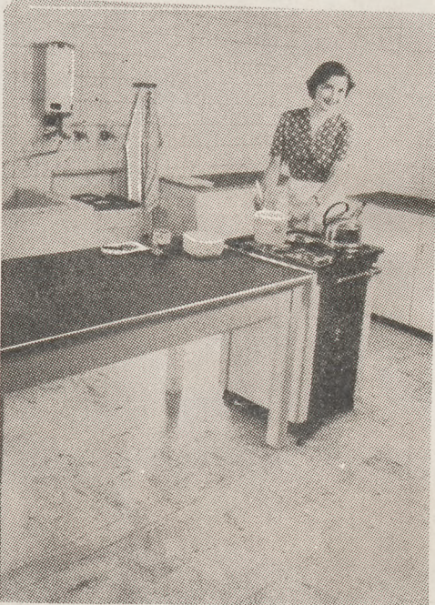
Posadzka z małych płyt twardych w kuchni mieszkania
