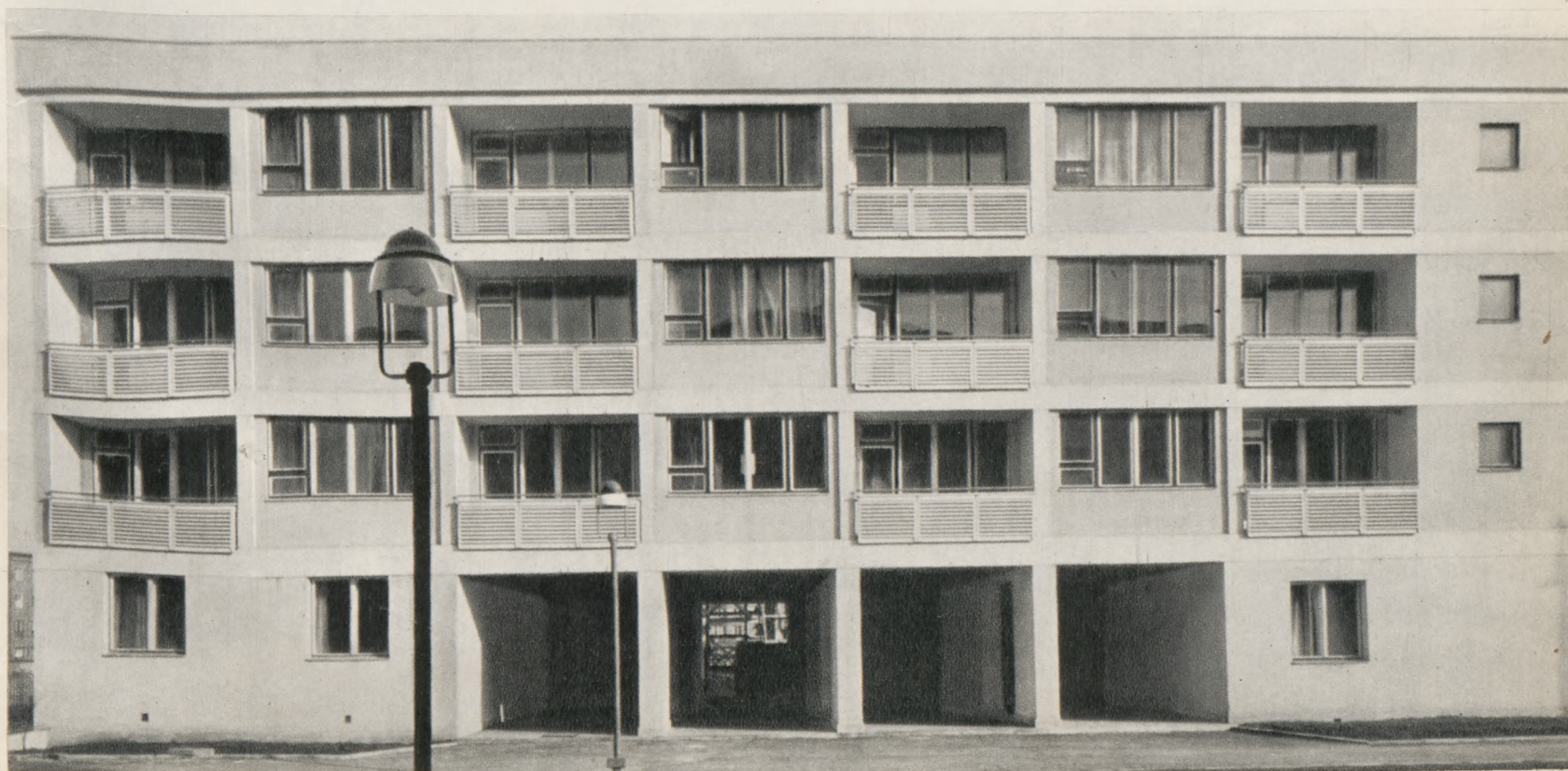
Elewacja zachodnia budynku mieszkalnego. Prześwit w parterze łączy wewnętrzny dziedziniec z ogrodem, wieńce zakończone białym lastrico, tynki wapienno-cementowe, balustrady balkonowe żaluzjowe drewniane, lakierowane na biało, futryny okienne malowane ciemno, wywietrzniki w każdym pomieszczeniu
