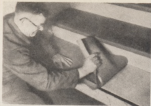
Okładzina stopni schodowych z krawędzią profilowaną (wyrób „Mipolam” — Niemcy)
