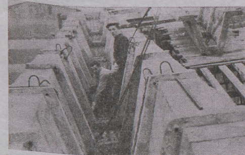
Widok przekrycia fałdowego hali
