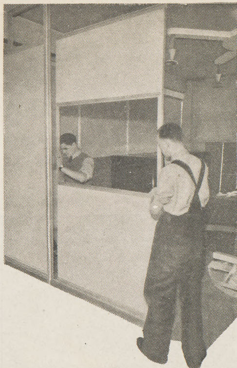
Wewnętrzne ścianki dzielące z płyt „Holoplast“
