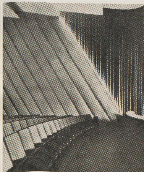
Obicie powierzchni ścian sali kinowej z czerwonej folii plastikowej, umocowane w ukośnych pasach na podłożu z materiału dźwiękochłonnego
