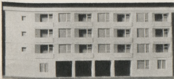
Elewacja zachodnia budynku mieszkalnego. Prześwit w parterze łączy wewnętrzny dziedziniec z ogrodem, wieńce zakończone białym lastrico, tynki wapienno-cementowe, balustrady balkonowe żaluzjowe drewniane, lakierowane na biało, futryny okienne malowane ciemno, wywietrzniki w każdym pomieszczeniu
