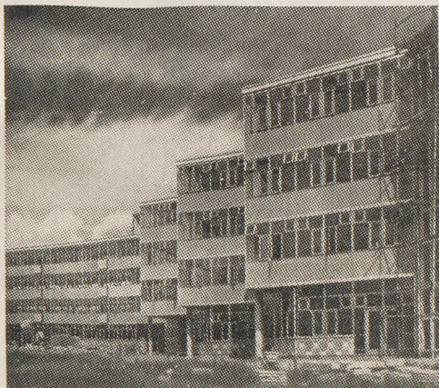
Budynek szkoły technicznej w Dartford (Anglia), wypełnienia ścian zewnętrznych między pasami okien z płyt „Holoplast“
