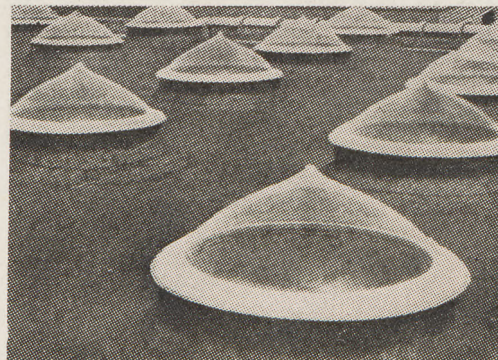
Świetliki kopułowe z tworzywa „Plexiglas” („Lauterplex”). Kształt kopuły jest tak opracowany, aby można było uniknąć gromadzenia się wody kondensacyjnej. Podstawa jest wykonana z poliestru
