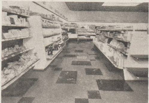
Posadzka z płyt twardych w sklepie samoobsługowym
