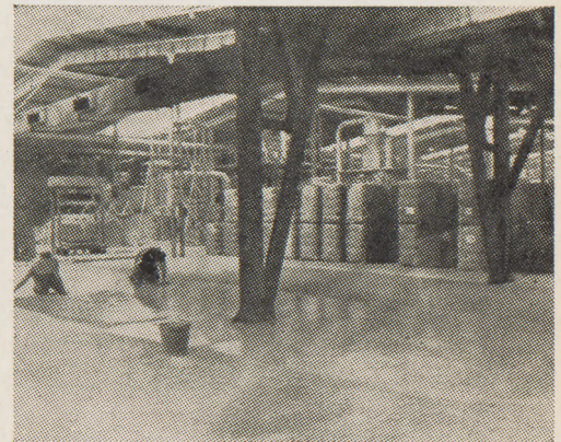
Szczególnie wytrzymała bezspoinowa wykładzina podłogowa (szpachlowa), poliwinylowa, w fabryce włókien chemicznych (materiał „Keravin” — Niemcy)
