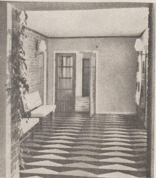
Posadzka wzorzysta z płyt winylowych „Holmsund”, przycinanych w małe, powtarzające się elementy
