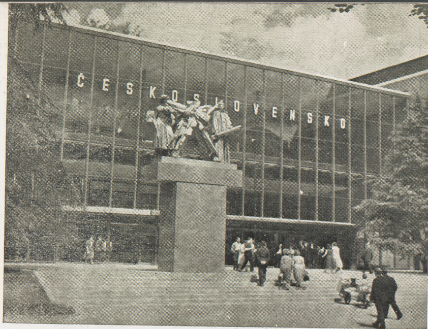
Widok głównego wejścia do pawilonu
