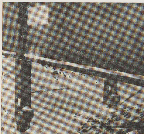
Fundamenty punktowe domu
