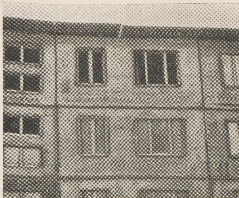
Dom wg pomysłu inż. Kozłowa w budowie. Zastosowano płyty na dwa pokoje
