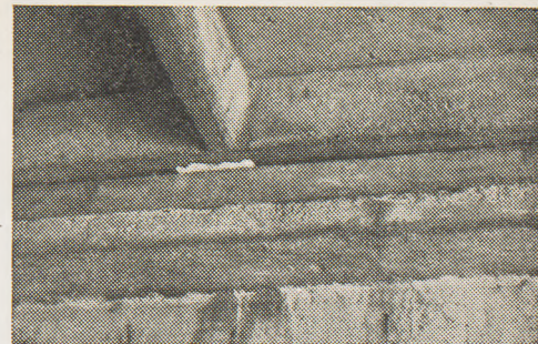
Zdjęcie przedstawia styk stropu i płyt wewnętrznych nośnych. Płyta stropowa spoczywa na dolnej krawędzi górnej płyty ściennej. Na górnej krawędzi dolnej płyty ściennej będzie położona płyta sufitowa z „plastrą miodu”.
