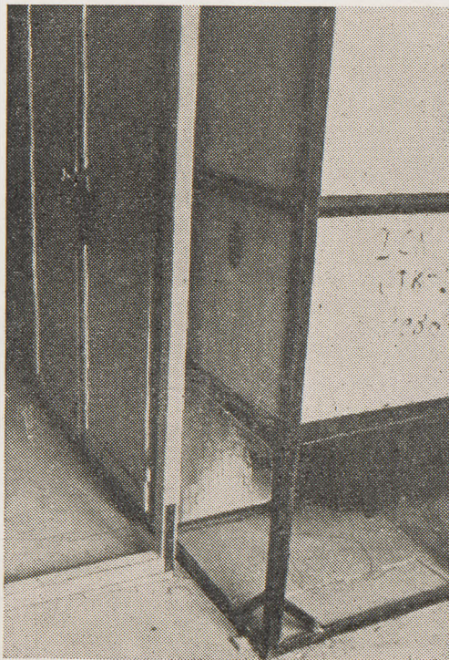
Kabina węzła sanitarnego po ustawieniu na stropie
