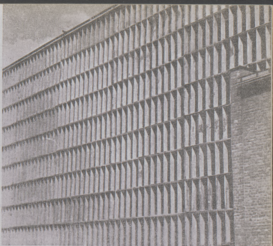
Brykietownia. Widok ściany bocznej z elementów prefabrykowanych
