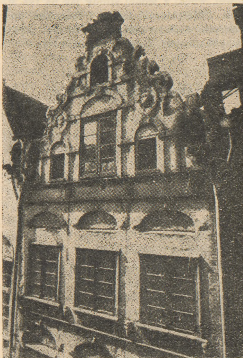
Rys. 2a-b. Kamienica gdańska — ściana osłonowa. Obramowanie nie przerywa wątku ściany
