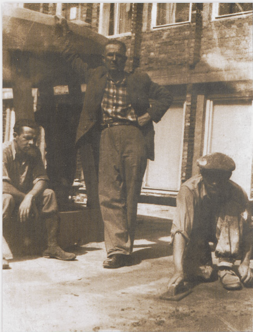
Mój tata Jan Szulc (stoi) na jednej z budów w Nowej Hucie, w czasie gdy był tam oddelegowany z warszawskiego Przedsiębiorstwa Budowlanego nr 2 jako kierownik jednego z odcinków. Rok 1952.
