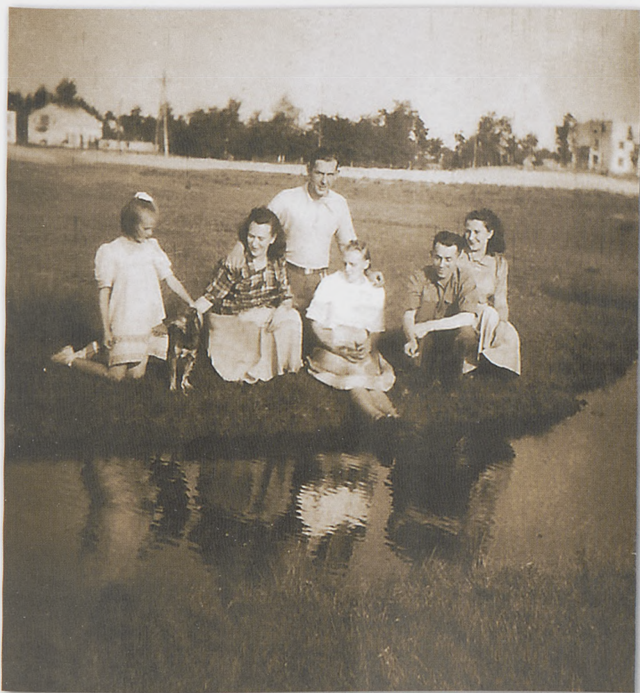
Ten sam teren, który widać także na zdjęciu poprzednim, widok od ulicy Krakowskiej. Po prawej u góry dom pp. Kuchcińskich, gdzie była nasza „biała szkoła”. Na dole parowa, w miejscu gdzie obecnie zbudowany jest tunel do przejazdu pod rondem na Przystanku i torami kolejowymi. Na zdjęciu rodzina pana Zarzyckiego (drugi z prawej). Zdjęcie z roku 1953.
