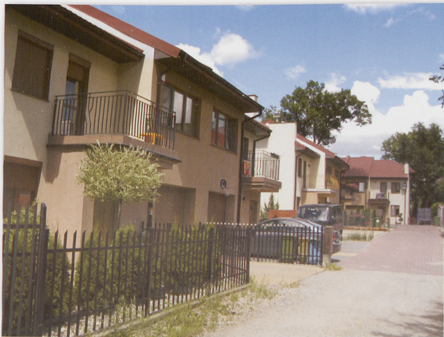
Kompleksy budynków jednorodzinnych przy ulicy Kościuszki i Warmińskiej.
