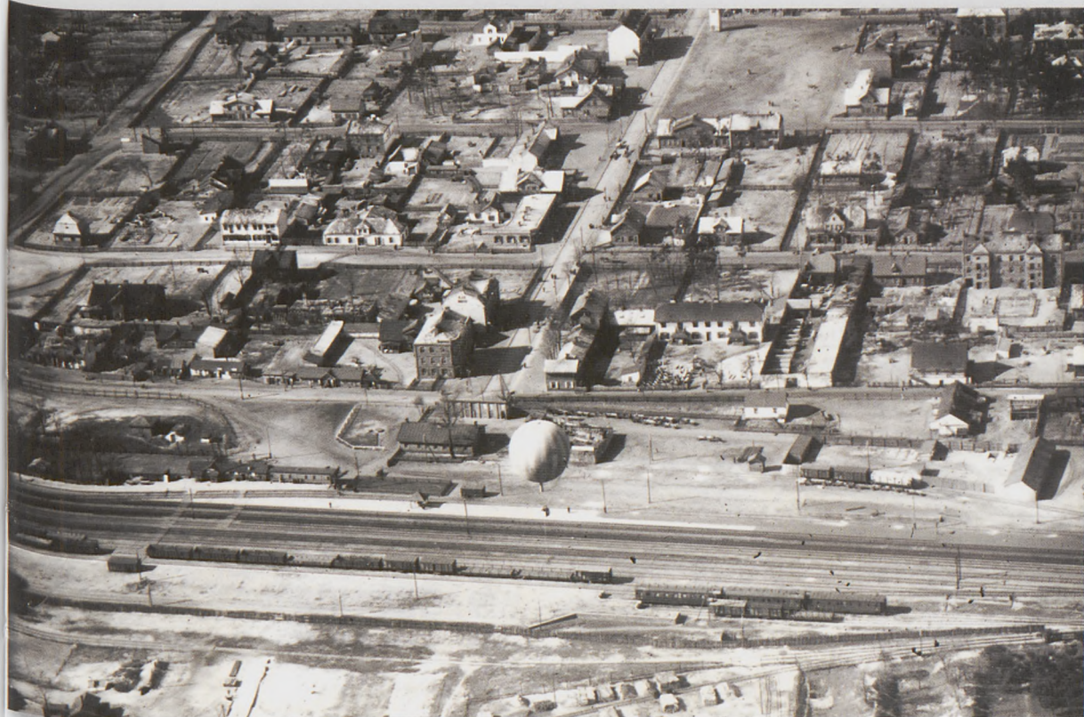
Fot. 1. Legionowo w latach 30. XX w. było rozległym placem budowy. Domy wznosili tu przedsiębiorcy żydowscy z Jabłonn, Serocka oraz z Warszawy. Fotografia została wykonana z wojskowego balonu obserwacyjnego należącego do 2. Batalionu Balonowego. MHwL/D 123.
