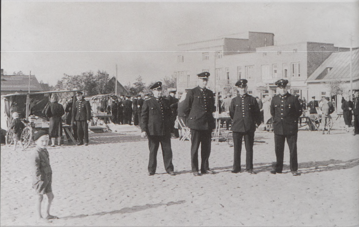
Fot. 13. Niemieccy kolejarze na tle narożnej kamienicy Szyji Szruta i Pessy Binsztejn vel Bimsztajn. Legionowski rynek, 1941 r. Okazały budynek został wzniesiony w 1936 r. przy ul. Batorego 12 (dziś nr 10). Przed wojną mieściła się tu apteka Jana Piętki i sklep z artykułami żelaznymi należący do właściciela kamienicy. W listopadzie 1940 r. Szrutowie zostali uwięzieni w legionowskim getcie. Szyja został zamordowany w październiku 1942 r. w Treblince. Jego żona zmarła w 1944 r. ukrywając się w Jabłonie. Pochowano ją tymczasowo koło miejscowej szkoły. Z rodziny kupca wojnę przeżyła jego matka Prywa Szrut z Jabłony oraz córka Zysła (ur. 1937 r.). Obie – babcia z wnuczką w 1945 r. zamieszkały w kamienicy widocznej na zdjęciu. Później wyjechały za granicę. Kilka lat temu Zysła odwiedziła Legionowo i dawny rodzinny dom. Ze zbiorów J. E. Szczepańskiego.
