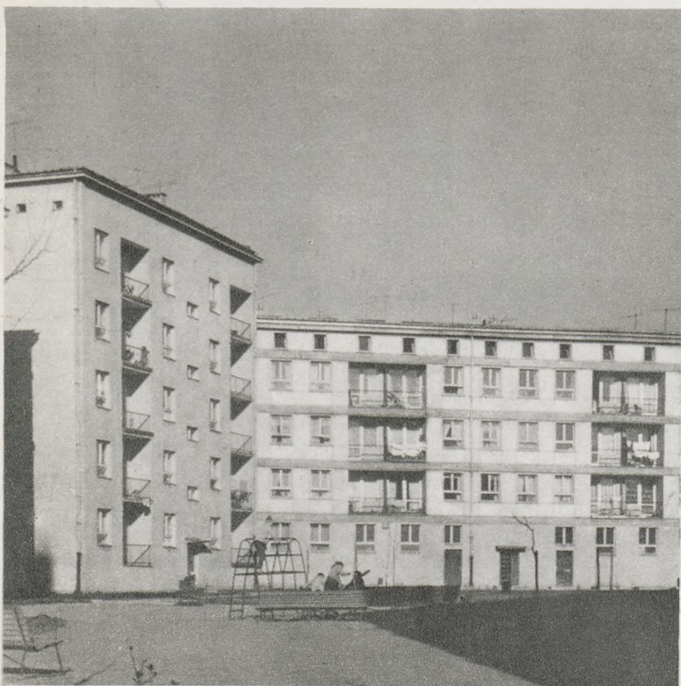
Budynki w północnej części osiedla z zaadaptowaną zabudową starą (po lewej)
