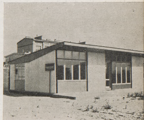
2. Płyty faliste z poliestrowej żywicy samogasnącej na ścianach budynku z tworzyw sztucznych
