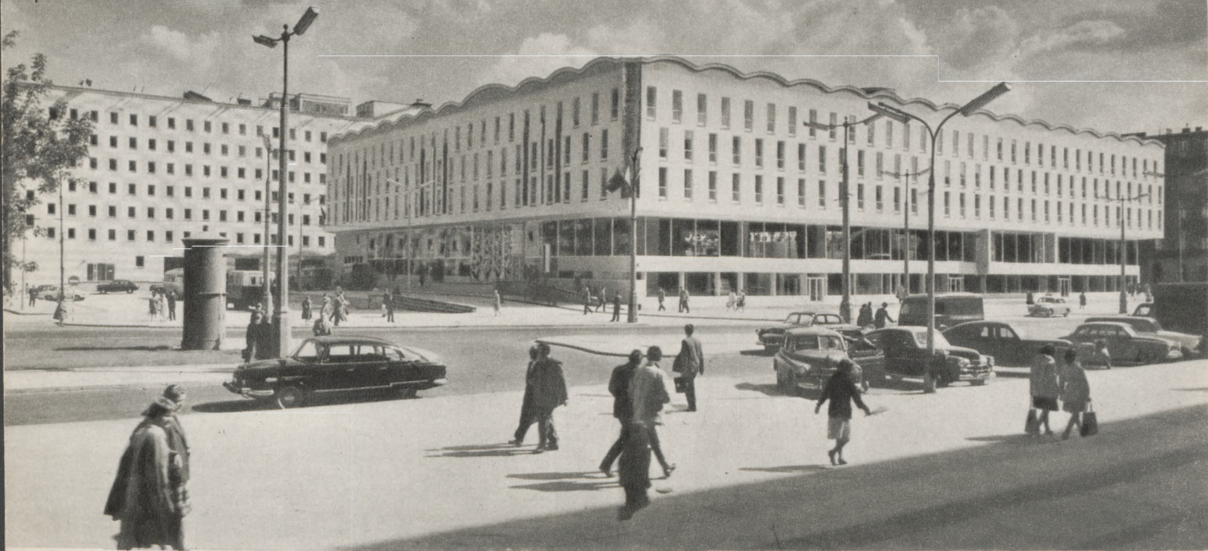
Dom Chłopa w Warszawie. Ogólny widok Domu od placu Powstańców
