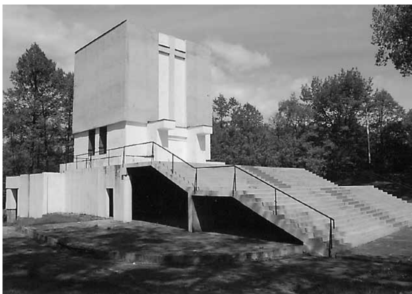
Wrzesień 1995 roku. Zakończono budowę schodów
