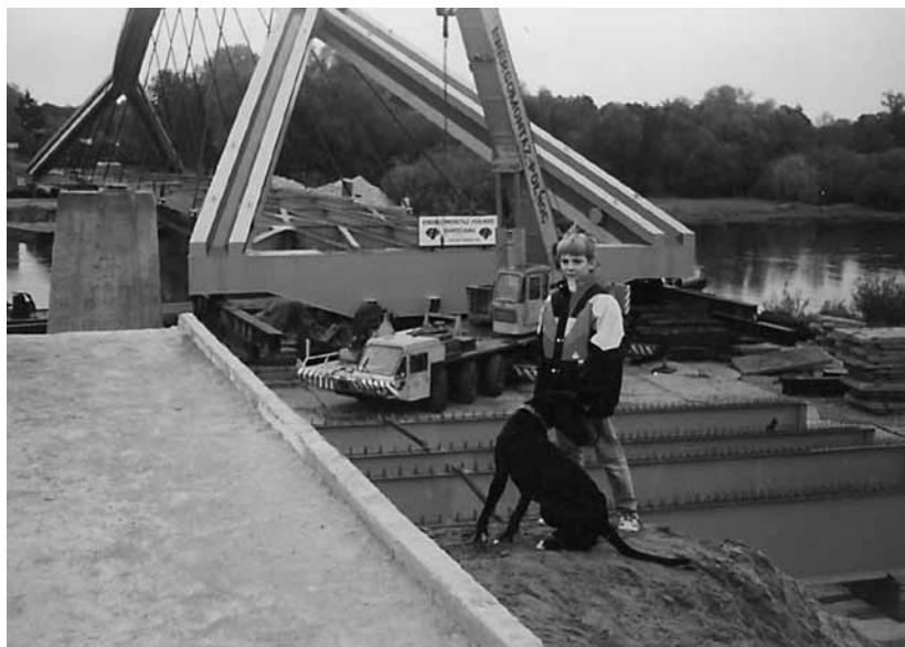
Maj 1994 roku. Budowa nowego mostu w miejscu dawnego drewnianego, na którym toczono walki 26 maja 1831 roku
