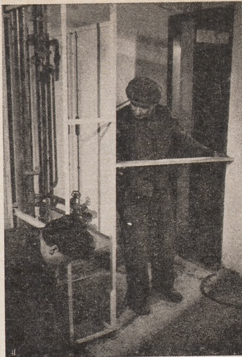
7. Montaż rdzenia B-2 (transport ręczny na budowie)
