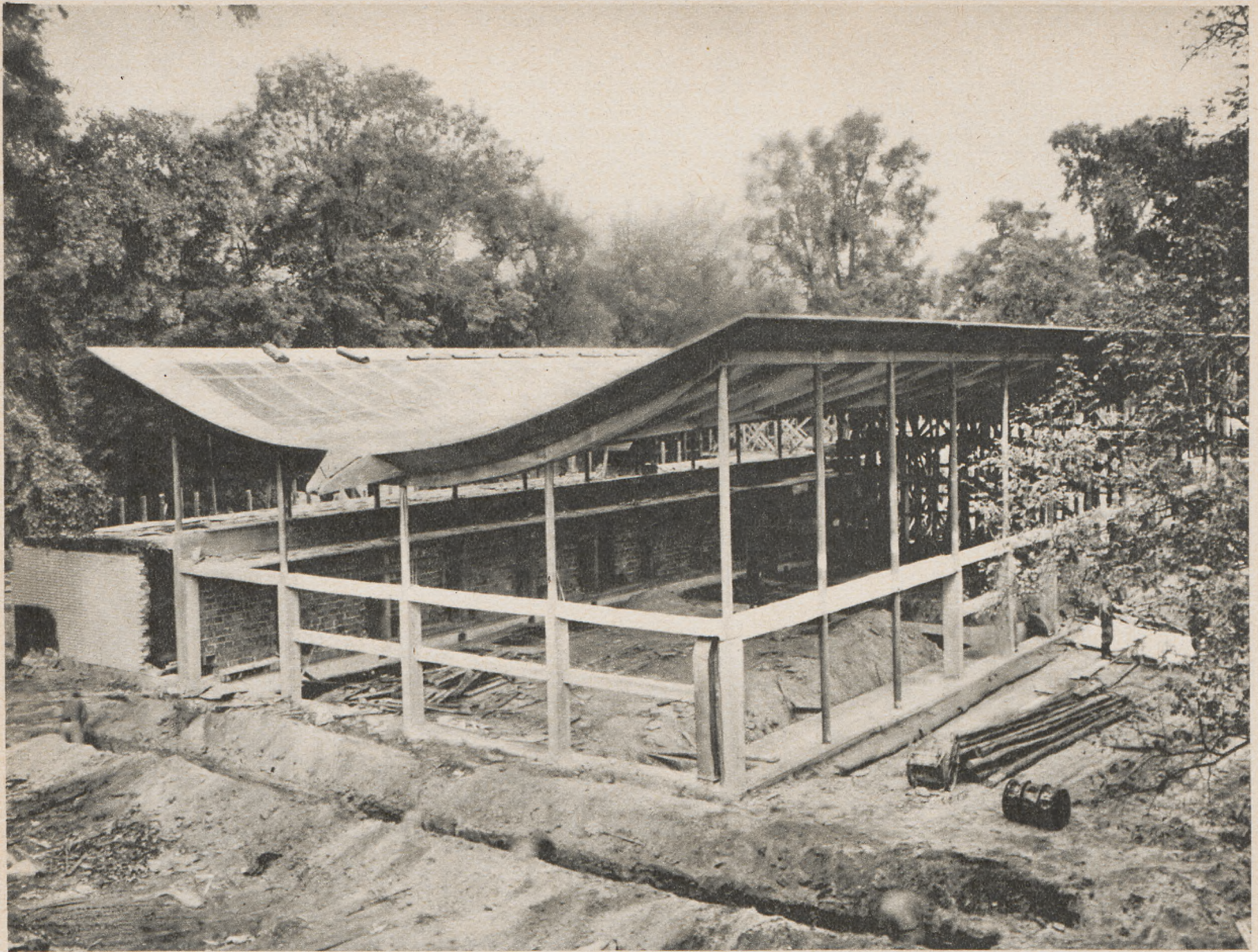
Pawilon w budowie
