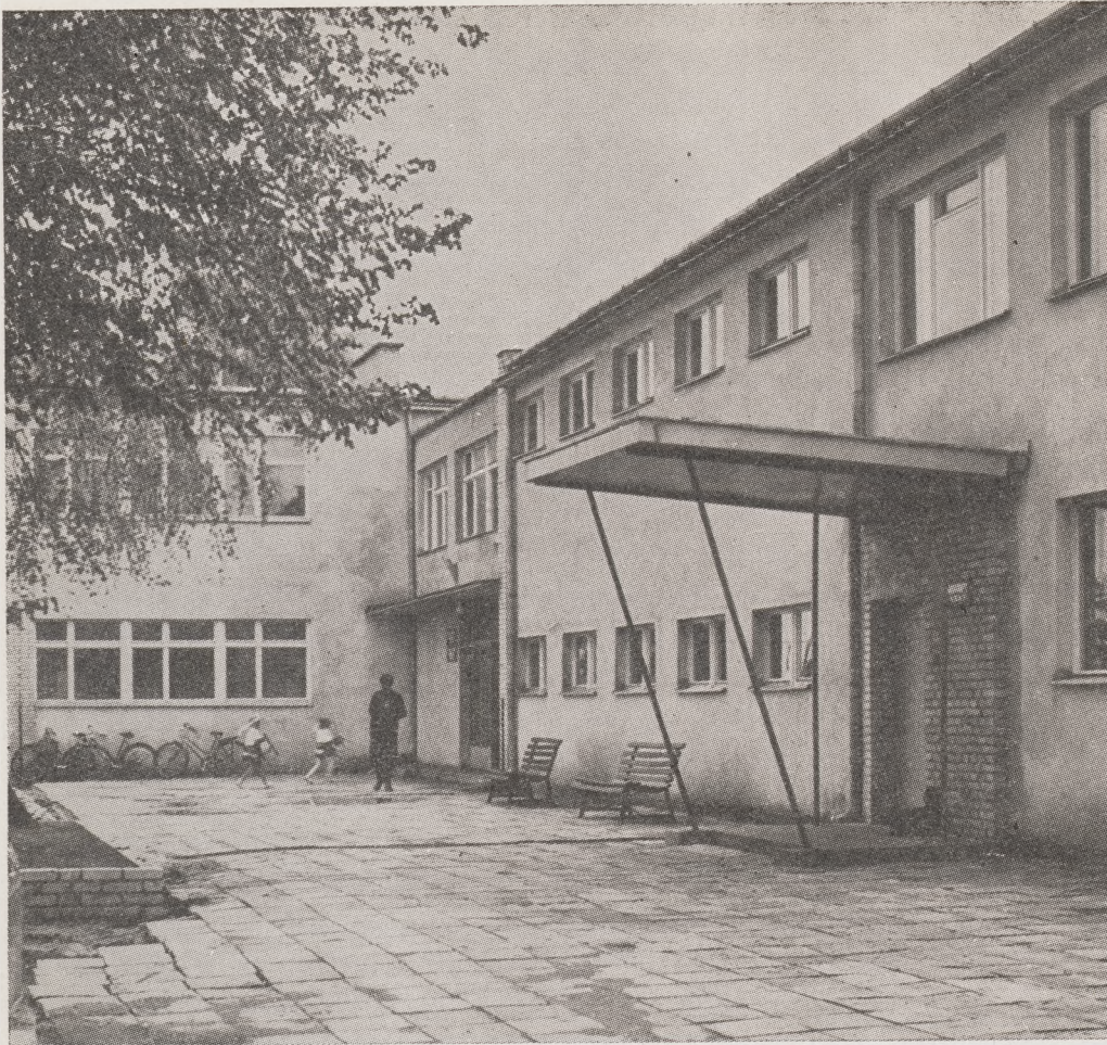
Fragmety elewacji od strony podwórza rekreacyjnego
