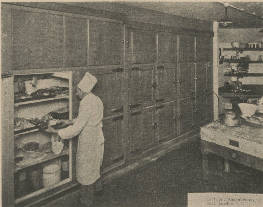
Szafy-chłodnie w nowoczesnej restauracji.
